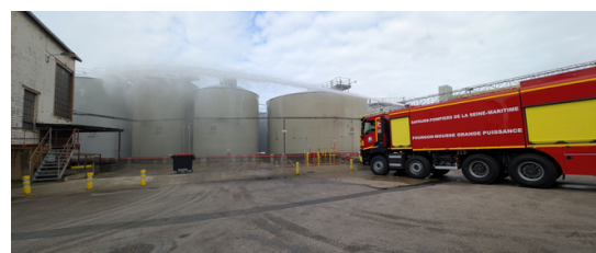
Essais de Pomperie en Seine et déploiement de moyens d'extinction du SDIS 76, exercice POI TotalEnergies du 31 mars 2026
